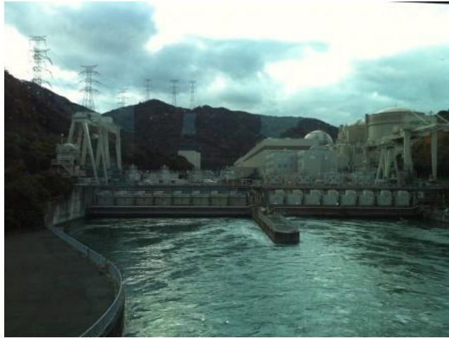
PLTN Ohi dan inlet dari air laut yang akan digunakan sebagai pendingin
