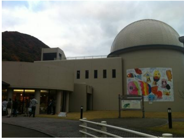
EIPark Ohi PR Hall milik KEPCO yang dibangun sebagai sarana sosialisasi dan edukasi PLTN
